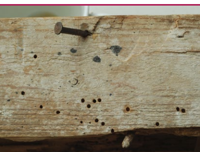
i 21 Rådborebille - flyvehuller i lægte. (Foto: EFI Global)
