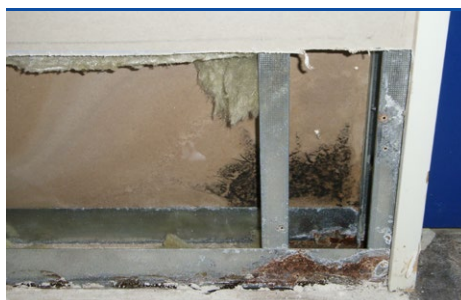
Skimmelvækst ( Stachybotris chartarum ) i let gipsvæg efter oversvømmelse. (Foto: PROTOX)
