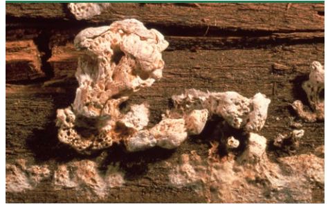
Rækkeporesvamp - sterile, blomkålsagtige frugtlegerer fremvokset i mørke. (Foto: PROTOX/Gori)
