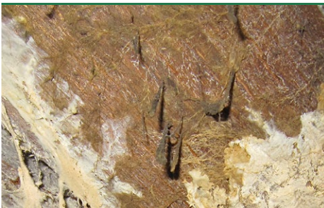
Viftesvamp - karrygult overflademycelium. (Foto: Bøgh & Helstrup)
