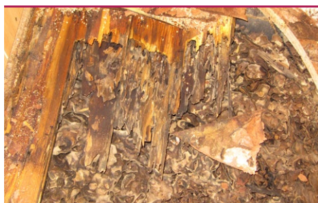
Orangemyrer - nedbrudte gulvbrædder. (Foto: PROTOX/kundefoto)
