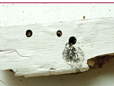
i 15 Rød Blomsterbuk - flyvehuller 5-8 mm skarpt kantede og runde. (Foto: PROTOX/EFI Global arkiv)
