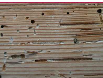
i 11 Alm Borebille - gulvbræt med frilagte larvegange som følge af afhøvling. (Foto: PROTOX)
