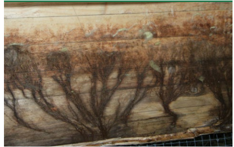
Gul Tømmersvamp - brunt strengmycelium på limtræsbjælke. (PROTOX)
