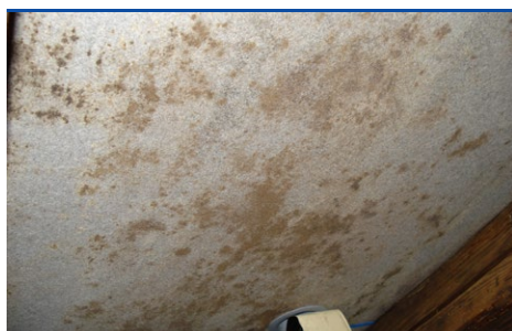
Skimmelvækst på diffusionstæt undertag (filtet overflade). (Foto: PROTOX)
