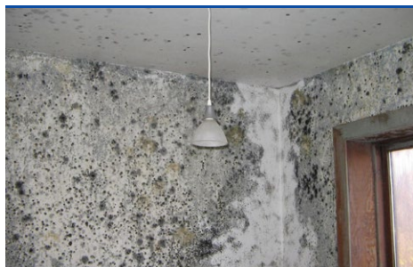
Skimmelvækst i opholdsstue efter vandskade. (Foto: PROTOX/kundefoto)
