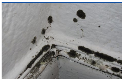
Sortskimmel på fodliste - mangelfuld udluftning. (Foto: PROTOX)
