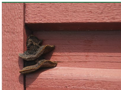
Korkhat - frugtlegemer på beklædningstræ, fritidshus. (Foto: PROTOX)
