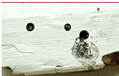
in 14 Rød Blomsterbuk - flyvehuller i dørkarm. (Foto: PROTOX/EFI Global arkiv)
