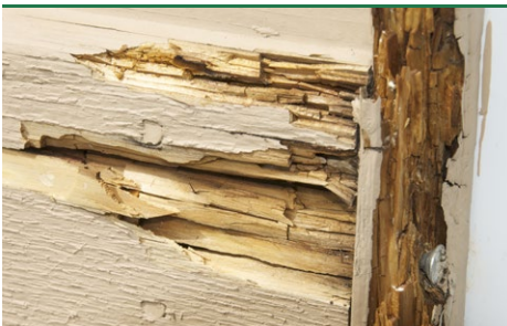
Korkhat - nedbrydning i træbeklædning i fritidshus. Angreb 3-4 år gammelt. (Foto: PROTOX)
