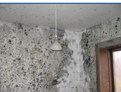
sk 3 Skimmelvækst i en-familiehus efter omfattende vandskade. (Foto: Protox/kundefoto)
