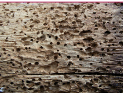
Egens Borebille - flyvehuller i gammel bjælke. (Foto: Protox) i 18
