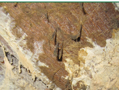
sv 20 Viftesvamp - karrygult fintstregnet overflademycelium. (Foto: Bøgh & Helstrup)
