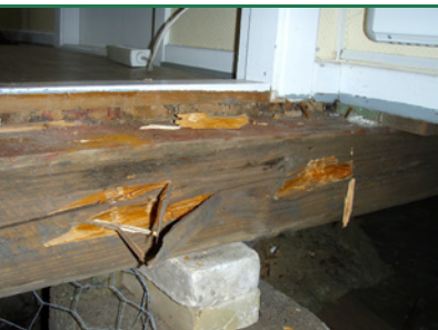
Gul Tømmersvamp - bjælke nedbrudt med intakt overflade. (Foto: Goritas A/S)
