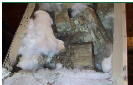
svn 29 Ægte Hussvamp - ungt overflademycelium, 2 uger. (Foto: Protox)
