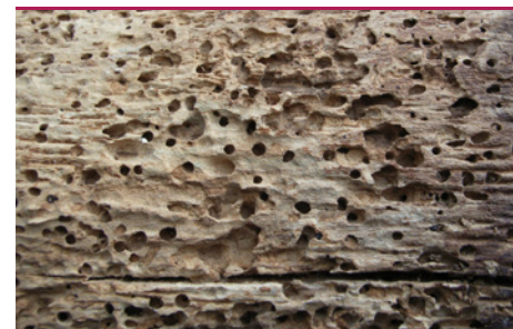
Egens Borebille - flyvehuller i gl. bjælke. (Foto: Protox)
