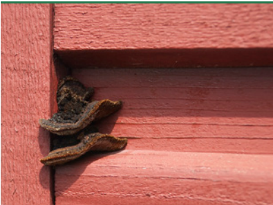
Korkhat - frugtlegerer på beklædningstræ, fritidshus. (Foto: Protox)
