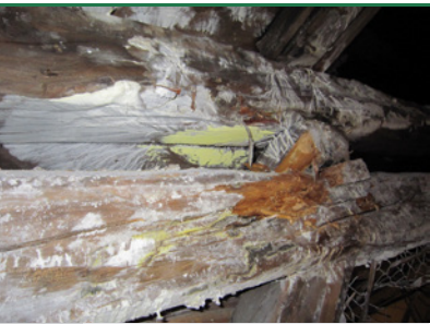
sv 14 Hvid Tømmersvamp - frugtlegerer og overflademycelium. (Foto: Bøgh & Helstrup)
