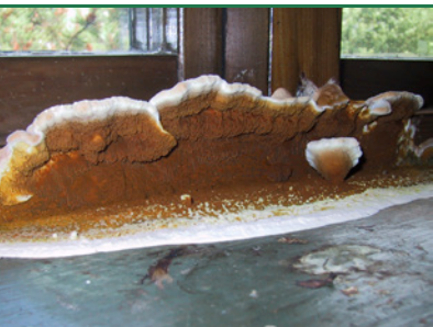
Ægte Hussvamp - frugtlegeme i vindueskarm/lysning - bemærk indskrumplinger i vindues ramme/pos.
