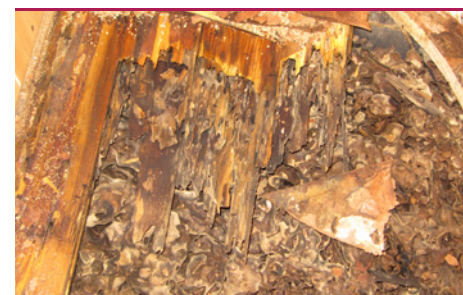
Orangemyrer - nedbrudte gulvbrædder. (Foto: Protox/kundefoto)
