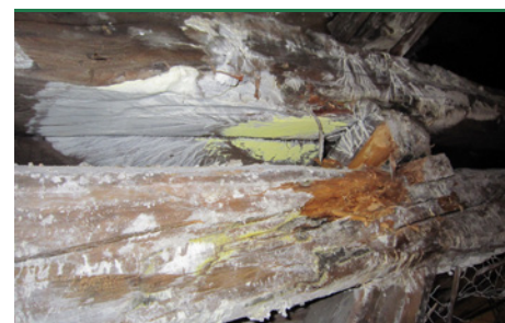
Hvid Tømmersvamp - angreb i tagkonstruktion. Kalkagtige fruglegemer, ungt, hvidt mycelium og bøjelige strenge. (Foto: Bøgh & Helstrup)
