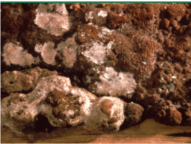
Korkhat - sterile frugtlegerer/brunt overflademycelium udviklet i mørke i fladt tag. (Foto: Protox/Gori)
