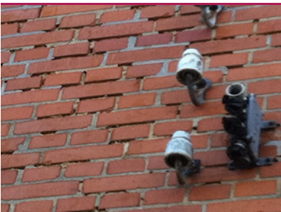
Murbi - ødelagte fuger i muret gavl. (Foto: Prottox) i 34
