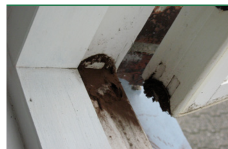
Slimsvamp - modent, bristet frugtlegerer med sporepulver. (Foto: Protox)
