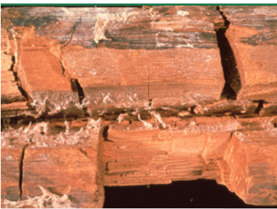
Ægte Hussvamp - sprækkeklodser. (Foto: Protox/Gori A/S)
