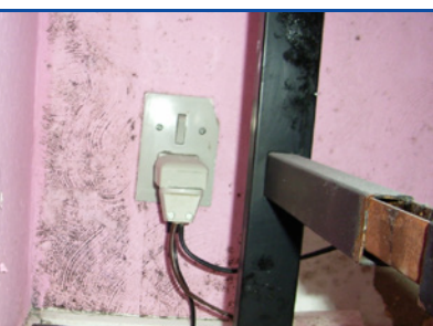
sk 2 Skimmelvækst på tapet - kuldebro i nordvest vendt hjørne. (Foto: Protox)
