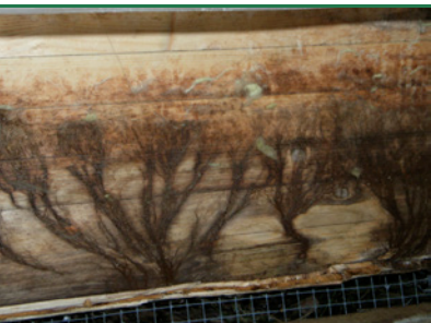
Gul Tømmersvamp - mørkebrunt slangebugtet strengmycelium på limtræsbjælke. (Foto: Protox)
