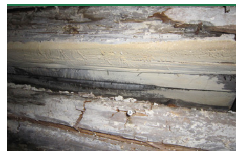
Hvid Tømmersvamp - frugtlegemer og myce- lium på nedbrudt træ med sprækkeklodser. (Foto: Bøgh & Helstrup)
