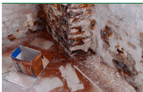
svn 5 Ægte Hussvamp - rødbrunt sporepulver på gulv. (Foto: Protox)
