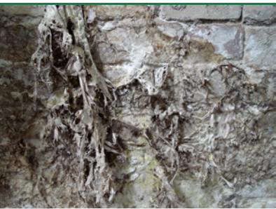
Ægte Hussvamp - ældre gråligt overflademycelium med strengmycelium. (Foto: Protox)
