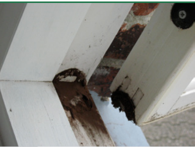
Slimsvamp - bristet frugtleger med sporepulver. (Foto: Protox)
