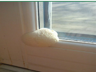
Slimsvamp - ungt frugtleger i delamineret vinduesramme. (Foto: Protox)
