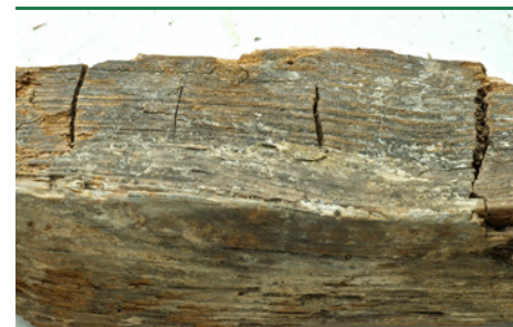
Ægte Hussvamp - gammelt angreb. Svage mycelrester og tydelige tværgående spræk-kerenver. (Foto: Protox/Goritasarkiv)
