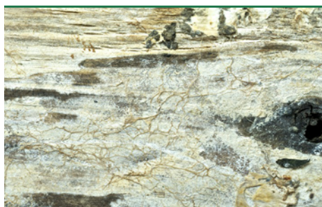
svn 40 Ægte Hussvamp - overflademycelium med vanddråber. (Foto: Bøgh & Helstrup)
