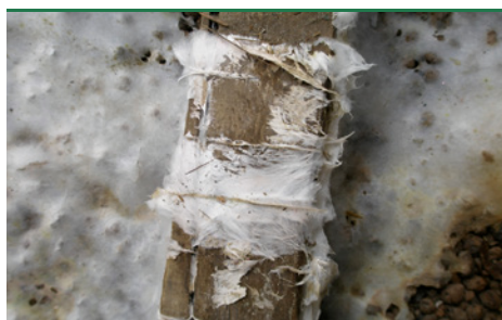
svn 27 Ægte Hussvamp - ungt mycelium med strengdannelser, lægte i udestue. (Foto: Protox)
