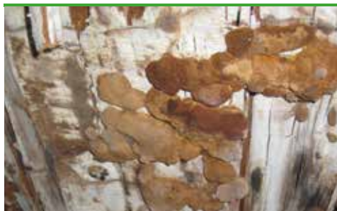
svn 14 Korkmussling - steril fruktkropp utvecklad i mörker (foto - Goritas A/S)
