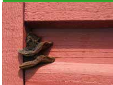
Korkmussling - fruktkroppar på träfasad, fritidshus (foto - Protox)
