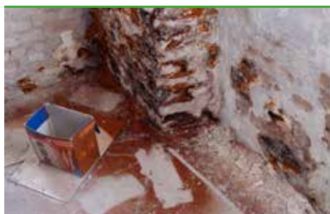
svn 5 Åkta Hussvamp - rödbrunt sporpulver på golv (foto - Protox)
