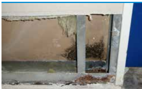
skn 10 Mögelpåväxt ( Stachybotris chartarum ) i lätt gipsvägg efter översvämning (foto - Protox)
