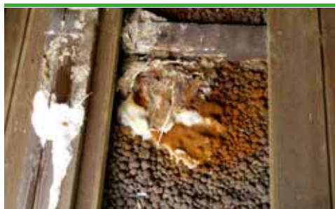
svn 4 Åkta Hussvamp - fruktkropp, kakao- liknande sporpulver och mycel på lecakulor under golv i uterum (foto - Protox/kundfoto)
