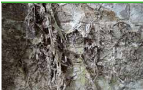
svn 26 Åkta Hussvamp - äldre, grått ytmycel med strängmycel (foto - Protox)
