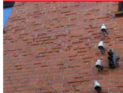
Väggsidenbi - förstörda fogar i murad gavel (foto - Protox)
