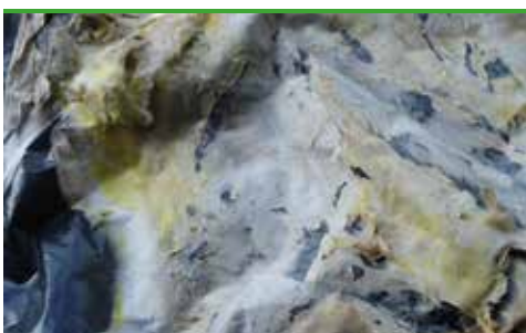
svn 30 Åkta Hussvamp- ytmycel med karakteristiska gula fläckar (foto - Protox)
