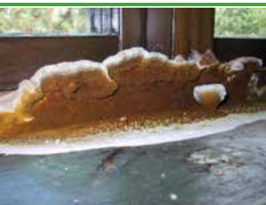
sv 1 Äkta Hussvamp - fruktkropp i fönsterkarm/ljusning - notera in- skrumplingar i fönsterram/pos (foto - Protox)
