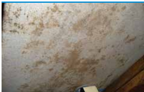
skn 9 Mögelpåväxt på diffusionstätt undertak (filityta) (foto - Protox)
