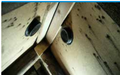
skn 8 Svartmögel på undertak p.g.a. bristfällig ventilation av vind (ventiler eftermonterade) (foto - Protox)
