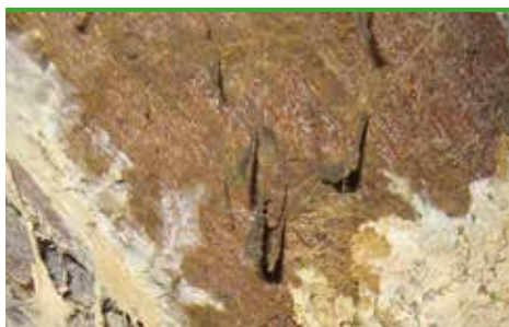
svn 35 Källarkantarell - currygult ytmycel (foto - Bøgh & Helstrup)
