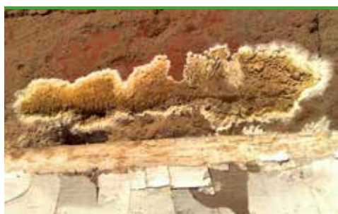
svn 6 Pulverskinn - fruktkropp på tegelsten (foto - Goritas)
