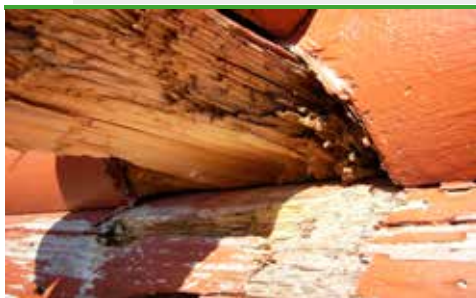
svn 46 Korkmussling - nedbrytning i timmerhus (foto - Protox)
