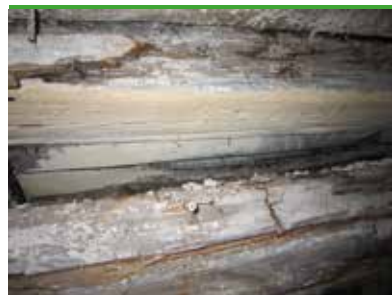
Mögelticka- fruktkroppar, ytmycel och sprickklossar i golvbalk (foto - Bøgh & Helstrup)
