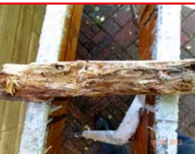
i 16 Gulröd blombeck i dörrstolpe - larv och larvgångar med bormjöl. Se även sidan 19 (foto - Protox)
