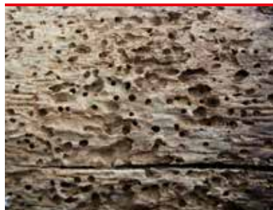
Skäckig trägnagare - flyghål i gammal balk (foto - Protox)
