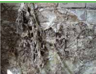
sv 3 Äkta Hussvamp- äldre gråaktigt ytmycel med strängmycel (foto - Protox)
