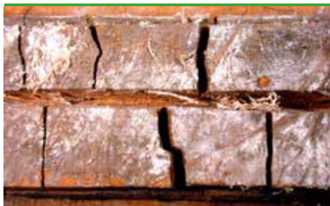
svn 50 Ekte hussopp - sprekkeklosser (foto - Hussvamp Laboratoriet)
