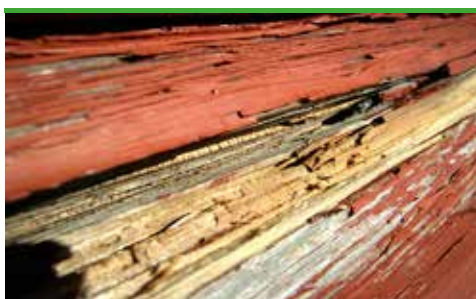
svn 48 badstumusling - bladet nedbryting i tømmerhus (foto - Protox)
