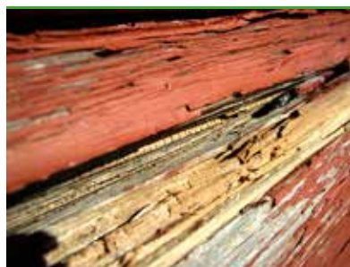
Badstumusling - nedbryting med typisk bladdannelse av årringene. Tømmerhus (foto - Protox)
