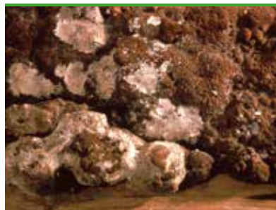
Muslingsopp - sterile fruktlegemer/brunt overflatemycel utviklet i mørke i flatt tak. (foto - Protox/Gori)
