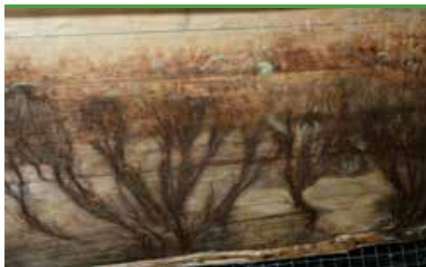
svn 32 Kjellersopp - brunt strengmycel på limtrebjelke (foto - Protox)
