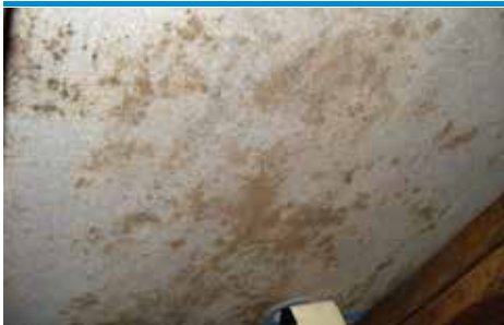
skn 9 Muggvekst på diffusjonstett undertak (fillet overflate) (foto - Protox)
