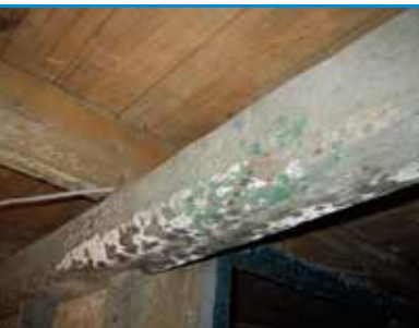
sk 1 Muggangrep - Trichoderma sp. i kjellerbjelke etter rørskaide. (foto - Protox)
