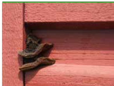
Muslingsopp - fruktlegemer på trepanel, fritidshus (foto - Protox)
