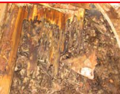
i 26 Sorte tremaur - gulvplanker ned- brutt av sorte tremaur (foto - Protox/kundefoto)
