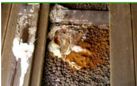
svn 4 Ekte hussopp - fruktlegermer, kakao-lignende sporepulver og mycel på lecakuler under gulv i vinterhage (foto - Protox/kundefoto)
