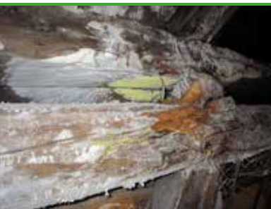
sv 14 Hvit tømmerkjuke - fruktlegemer og overflatemycel (foto - Bøgh & Helstrup)
