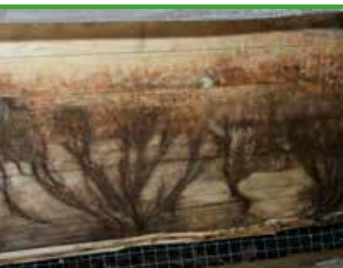
sv 7 Kjellersopp - mørkebrunt slangebuktende strengmycel på limtrebjelke (foto - Protox)
