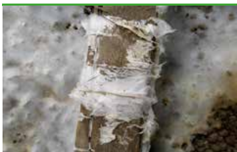
svn 27 Ekte hussopp - ungt mycel med strengdannelse, leker i vinterhage (foto - Protox)
