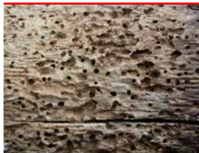
Eikeborebille - flyvehull i gammel bjelke (foto - Protax)
