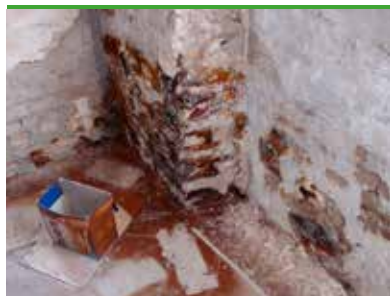
Ekte hussopp - sporepulver på gulv (fra fructilegemaer på vegg) (foto - Protox)
