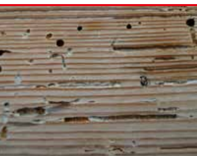
i 11 Stripet borebille - gulvbord med frilagte larveganger som følge av avhøvlning (foto - Protox)
