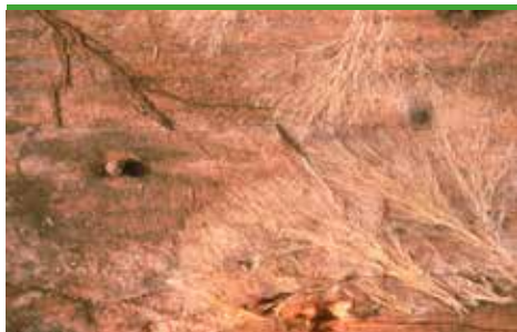
svn 31 Kjellersopp - karakteristisk mørkt og lyst strengmycel (foto - Protox/Gori)
