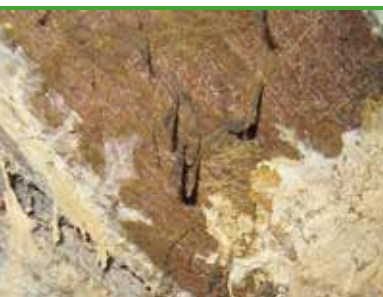
sv 20 Huspluggsopp - karrigult finstrengt overflatemycel (foto - Bøgh & Helstrup)
