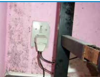
sk 2 Muggvekst på tapet - kuldebro i nordvest vendt hjørne (foto - Protox)
