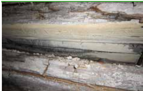
svn 9 Hvit tømmerkjuke - fruktlegemer og mycel på nedbrutt tre med sprekkeklosser (foto - Bøgh & Helstrup)
