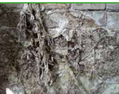
sv 3 Ekte hussopp - eldre grålig overflatemycel med strengmycel (foto - Protox)
