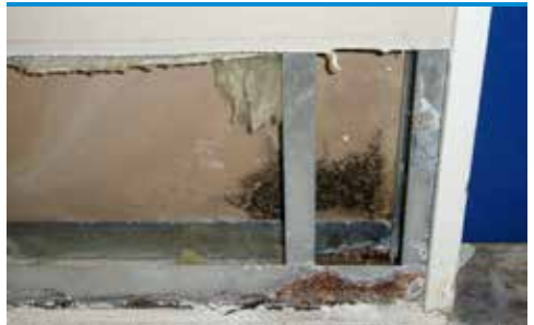
skn 10 Muggvekst ( Stachybotris chartarum ) i lett gipsvegg etter oversvømmelse (foto - Protox)
