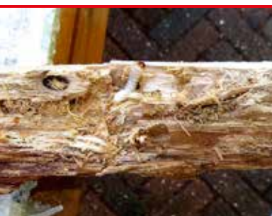
i 16 Rød Blomsterbukk i dørstolpe - larve og larveganger med boremel. Se også side 19 (foto - Protox)
