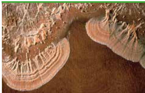
svn 37 Badstumusling - overflatemycel i flat tak av kryssfiner (foto - Protox/Gori)
