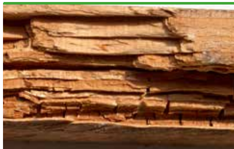
svn 43 Rekkekjuke (hvit tømmerkjuke) - nedbryting (foto - Protox)
