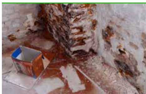
svn 5 Ekte hussopp - rødbrunt sporepulver på gulv (foto - Protox)
