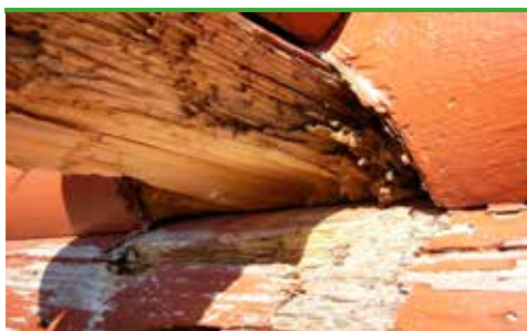
svn 46 badstumusling - nedbryting i tømmerhus (foto - Protox)
