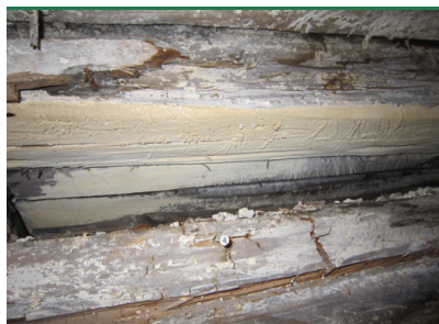
Weißer Porenschwamm- Fruchtkörper, Oberflächenmyzel und Würfelbruch in Stockwerkbalken. (Foto: Bøgh & Helstrup)
