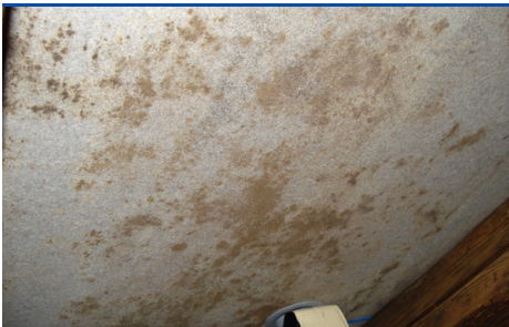
Schimmelpilzwachstum auf diffusionsdichtem Unterdach (gefälzte Oberfläche). (Foto: Protox)
