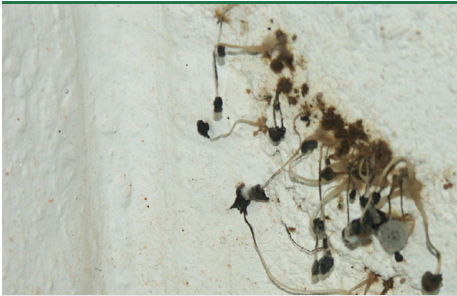
Haustintling – Fruchtkörper auf verputzter Wand. (Foto: Goritas)
