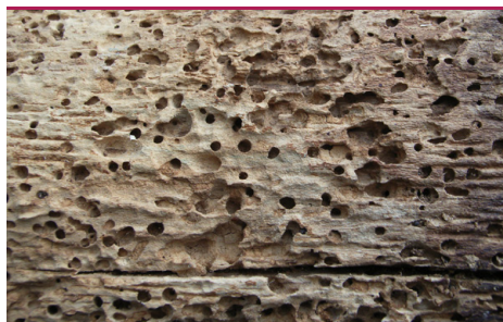
Gescheckter Nagekäfer - Schlupflöcher in altem Gebälk. (Foto: Protox)
