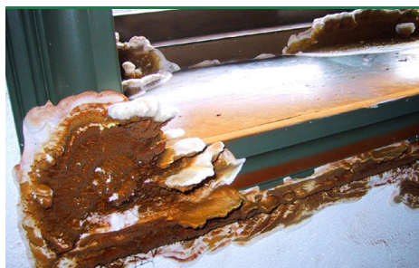
svn 2 Echter Hausschwamm - Fruchtkörper in einem Fenster in einem Ferienhaus. (Foto: Protox)
