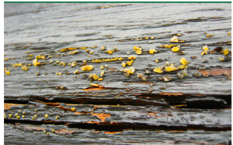
Gelbe Gallerträne – Fruchtkörper auf lackiertem Holz im Außenbereich. (Foto: Goritas)
