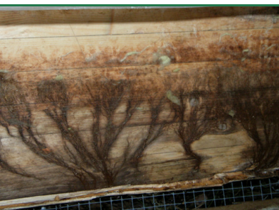
Brauner Kellerschwamm – dunkelbraunes, schlangenförmiges Strangmyzel auf Leimholzbalken. (Foto: Protox)
