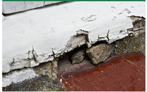
Oberflächenfäulnis (Graufäule) - Wassernase an altem Fenster. (Foto: Protox)
