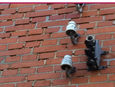
Seidenbiene – zerstörte Fugen in Mauergiebel. (Foto: Protox)
