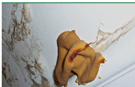
svn 18 Gelber Wachsbecherling - Fruchtkörper auf Fußleiste an Wand. (Foto: Bøgh & Helstrup)
