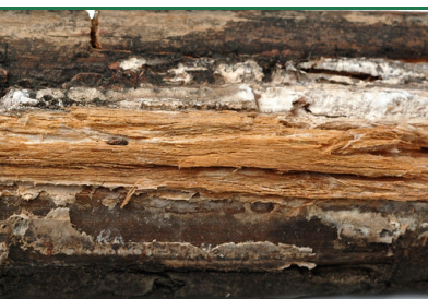
Rindenpilz (Weißfäule) in Fensterrahmen. (Foto: Protox)
