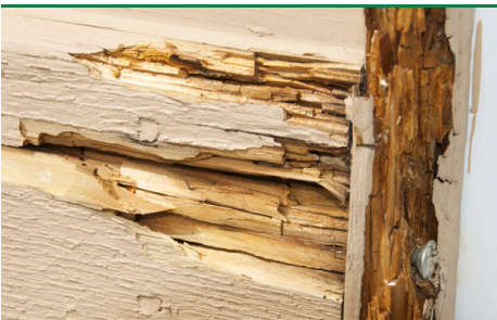
Blättling - Zersetzung in der Holzverkleidung eines Sommerhauses. 3-4 Jahre alter Befall. (Foto: Protox)
