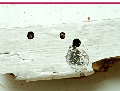
i 15 Rothalsbock- Schlupflöcher 5-8 mm, scharfkantig und rund. (Foto: Protox/Goritas Archiv)
