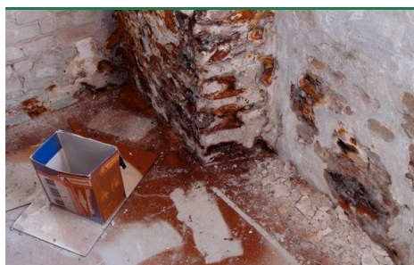
svn 5 Echter Hausschwamm - rotbraunes Sporenpulver auf Fußboden. (Foto: Protox)
