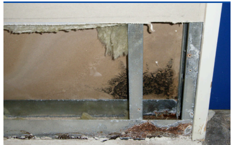
Schimmelpilzwachstum ( Stachybotris chartarum ) auf leichter Gipswand nach Überschwemmung. (Foto: Protox)
