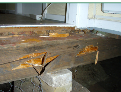
Brauner Kellerschwamm- zersetzter Balken mit intakter Oberfläche. (Foto: Goritas A/S)
