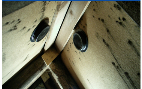
Schwärzepilz auf Unterdachkonstruktion auf Grund unzureichender Lüftung des Dachbodens (Lüftung nachträglich angebracht). (Foto: Protox)
