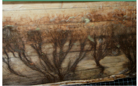
Brauner Kellerschwamm – braunes Strangmyzel auf Leimholzbalken. (Foto: Protox)
