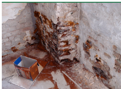
Echter Hausschwamm - Sporenpulver auf Fußboden (durch Fruchtkörper an Wand). (Foto: Protox)
