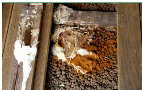
svn 4 Echter Hausschwamm - Fruchtkörper, kakaoartiges Sporenpulver und Myzel auf Blähton unter dem Boden im Wintergarten. (Foto: Protox / Kundenfoto)
