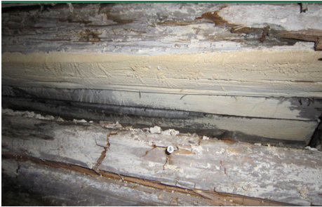
Weißer Porenschwamm- Fruchtkörper und Myzel auf zersetztem Holz mit Würfelbruch. (Foto: Bøgh & Helstrup)
