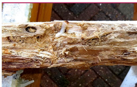
in 15 Rothalsbock - Larve, Bohrmehl und zersetztes Holz. (Foto: Protox/Kundenfoto)
