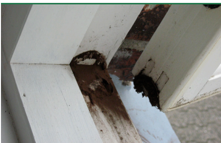
Schleimpilz – reifer, aufgeplatzter Fruchtkörper mit Sporenpulver. (Foto: Protox)
