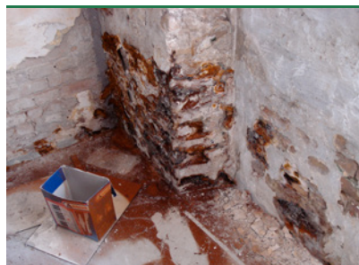
Ægte Hussvamp - sporepulver på gulv (fra frugtlegemer på væg). (Foto: Protox)
