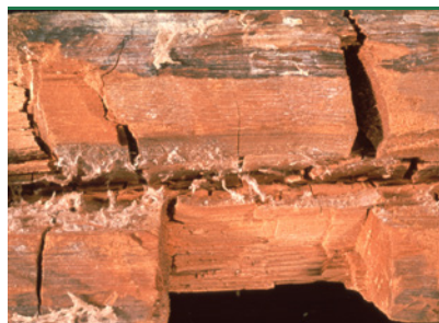
Ægte Hussvamp - sprækkeklodser. (Foto: Protox/Gori A/S)
