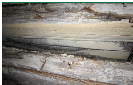
Hvid Tømmersvamp - frugtlegerer og mycelium på nedbrudt træ med sprækkeklodser. (Foto: Bøgh & Helstrup)
