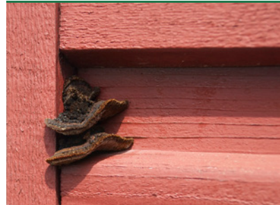
Korkhat - frugtlegemer på beklædningstræ, fritidshus. (Foto: Protox)
