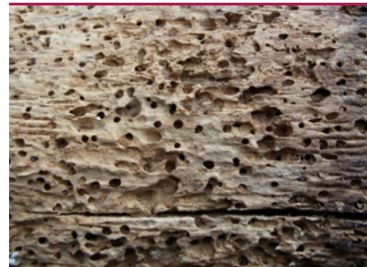
Egens Borebille - flyvehuller i gammel bjælke. (Foto: Protox)
