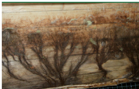
Gul Tømmersvamp - brunt strengmycelium på limtræsbjælke. Protox - Protox)
