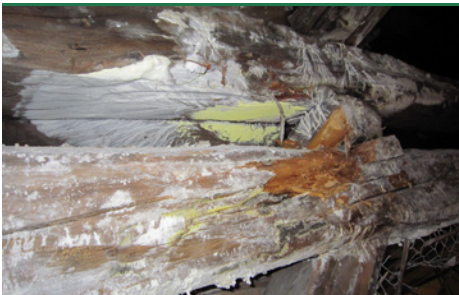
Weißer Porenschwamm - Befall in Dachkonstruktion. Kalkartige Fruchtkörper, junges, weißes Myzel und biegsame Stränge. (Foto: Bøgh & Helstrup)
