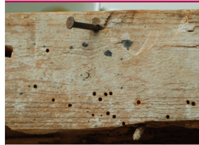
Troitzkopf - Schlupflöcher in Holzlatte. (Foto: Goritas)
