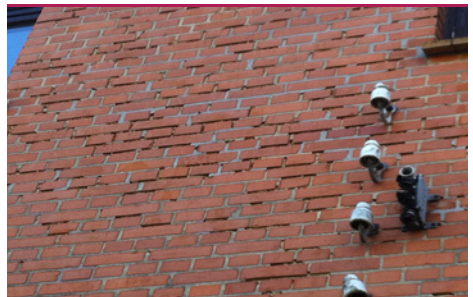
Gemeine Seidenbienen - Fugen im Mauerwerk teilweise zersetzt. (Foto: Protox)
