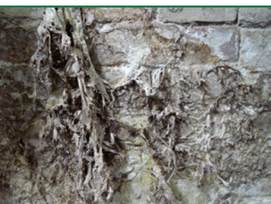
sv 3 Echter Hausschwamm – älteres, gräuliches Oberflächenmyzel mit Strangmyzel. (Foto: Protox)
