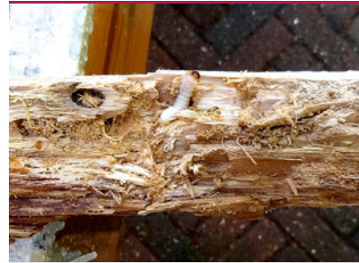
Rothalsbock in Türpfosten - Larve und Larvengänge mit Bohrmehl. S. auch S. 18. (Foto: Protox)
