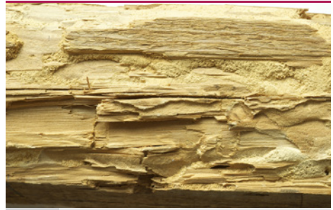
in 13 Hausbock - freigelegte Larvengänge. (Foto: Protox/Goritas Archiv)
