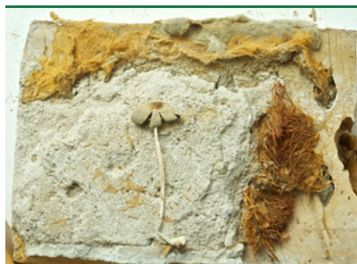
Haustintling - Fruchtkörper und orange-braunes, zähes geschlechtsloses Ozonium. (Foto: Protox/Goritas Archiv)
