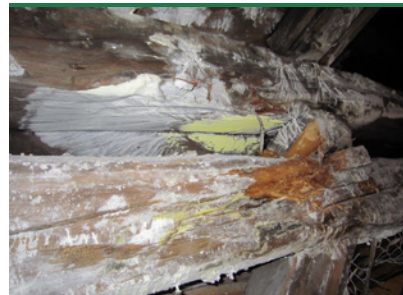
Weißer Porenschwamm - Fruchtkörper und Oberflächenmyzel. (Foto: Bøgh & Helstrup)
