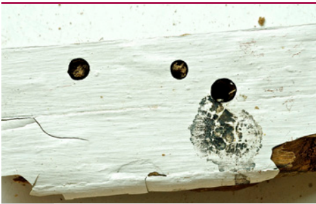
in 14 Rothalsbock - Schlupflöcher in Türrahmen. (Foto: Protox/Goritas Archiv)
