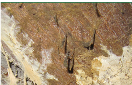
Muschelkrempling - currygelbes Oberflächenmyzel. (Foto: Bøgh & Helstrup)
