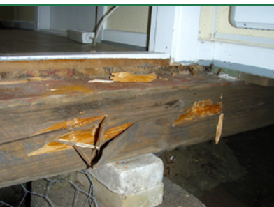
Brauner Kellerschwamm- zersetzter Balken mit intakter Oberfläche. (Foto: Goritas A/5)
