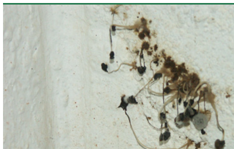
Haustintling - Fruchtkörper auf verputzter Wand. (Foto: Goritas)
