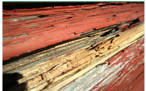
Blättling - Zersetzung mit Abblättern in einem Blockhaus. (Foto: Protox)
