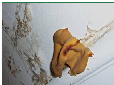
Wachsbecherling - Fruchtkörper auf verputzter Wand. (Foto: Bøgh & Helstrup)
