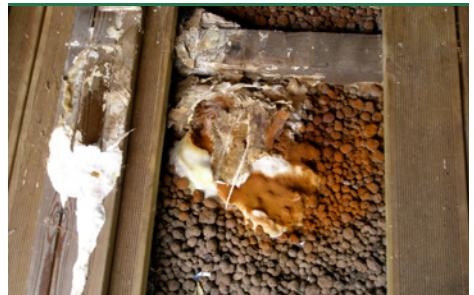
svn 4 Echter Hausschwamm - Fruchtkörper, kakaoartiges Sporenpulver und Myzel auf Blähton unter dem Boden im Wintergarten. (Foto: Prottox / Kundenfoto)
