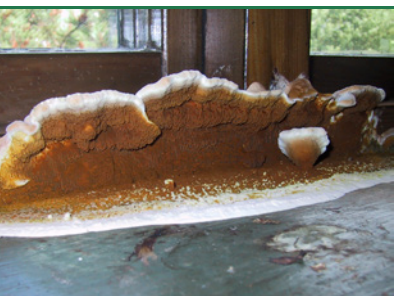
sv 1 Echter Hausschwamm – Fruchtkörper im Fensterrahmen. Bemerkenswert die Schrumpfung des Fensterrahmens.
